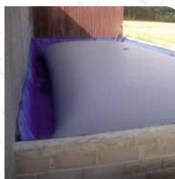
Rétention entre muret
